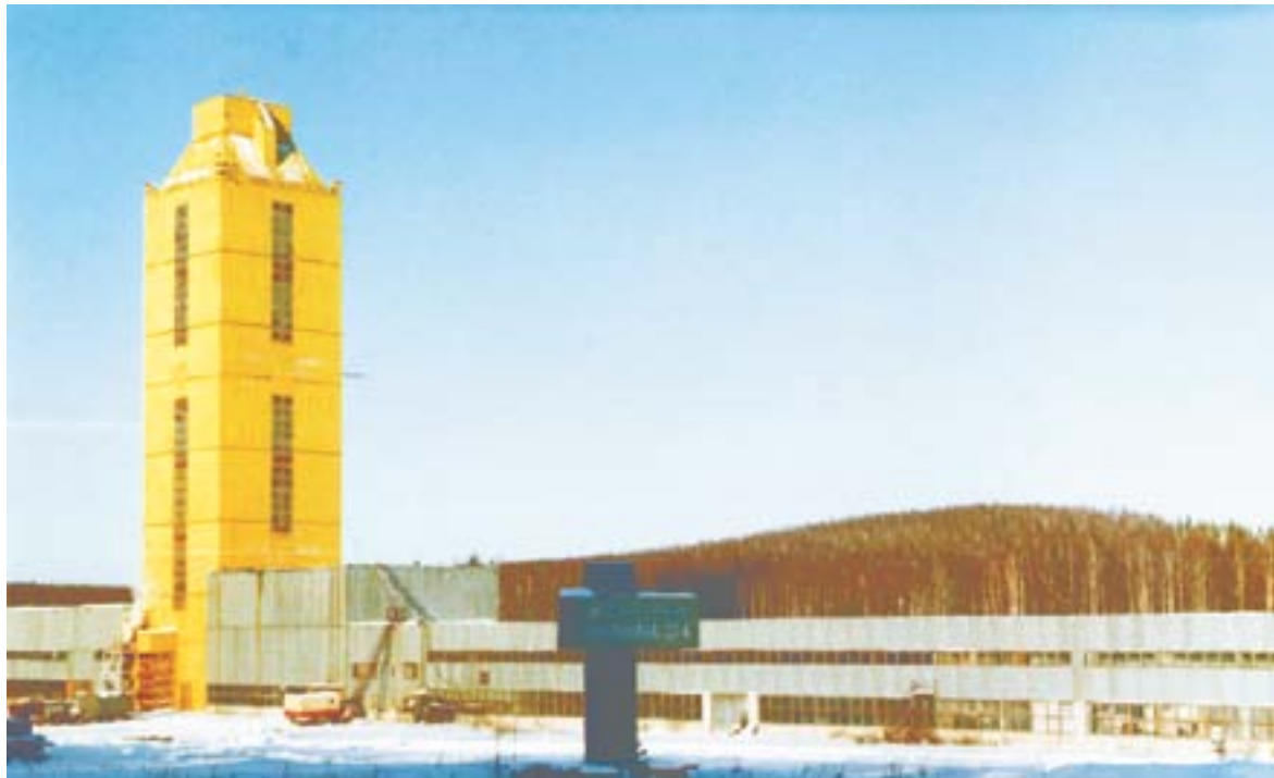
Уральская сверхглубокая скважина.
